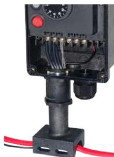
13: Collegare i conduttori e il sensore di temperatura secondo lo schema di cablaggio. Collegare il cavo di alimentazione. Chiudere la scatola di comando.
